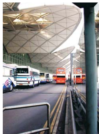
香港國際機場 Hong Kong International Airport 所用產品: KFDN-100
