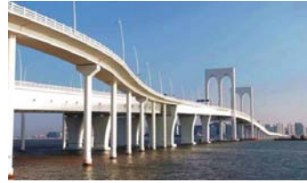
澳門西灣大橋 Sai Van Bridge 產品 Products：KFDN-SP8G KFDN-GS1000
