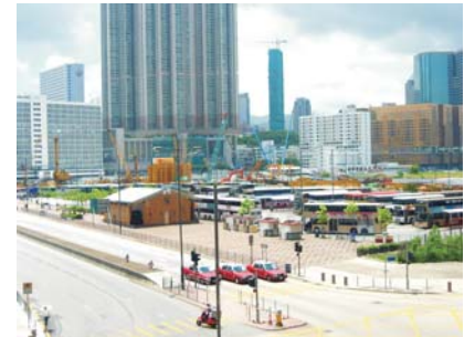
建設中的九廣鐵路九龍西站 KCRC Kowloon West Station 產品 Product : KFDN-SP8G, KFDN-100
