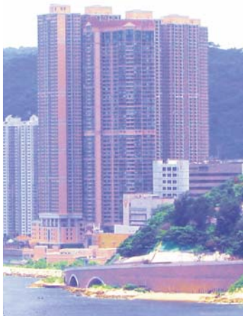
深井碧堤半島54層住宅 Bellagio 54 Stories Residential Apartment 產品 Product : KFDN-SP8G, KFDN-SP100
